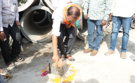
రూ.40 లక్షలసాకేట్ కాలనీలో ఓపెన్ జీవీ చిన్నారుల ఆట పరికరాల ఏర్పాటు, రూ.25 లక్షలహోల్ ఎన్ క్లీవ్ లో సీసీ రోడ్ల నిర్మాణ పనులు, రూ.60 లక్షలకాప్రా నాలా నుండి సాయి సుమా టీ-జంక్షన్ వరకు స్టాల్స్ వాటర్ డ్రెయిన్ నిర్మాణ పనులు రూ.2.50 కోట్లగాంధీనగర్ లో సీసీ రోడ్ల నిర్మాణ పనులు, రూ.20 లక్షలమొత్తంగా సుమారు రూ.4 కోట్ల వ్యయంతో చేపడుతున్న ఈ
